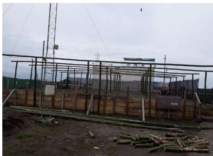
Figura 9. Estructura construida con varas de bambu que sirvieron para colocar el sarán al 80%.
