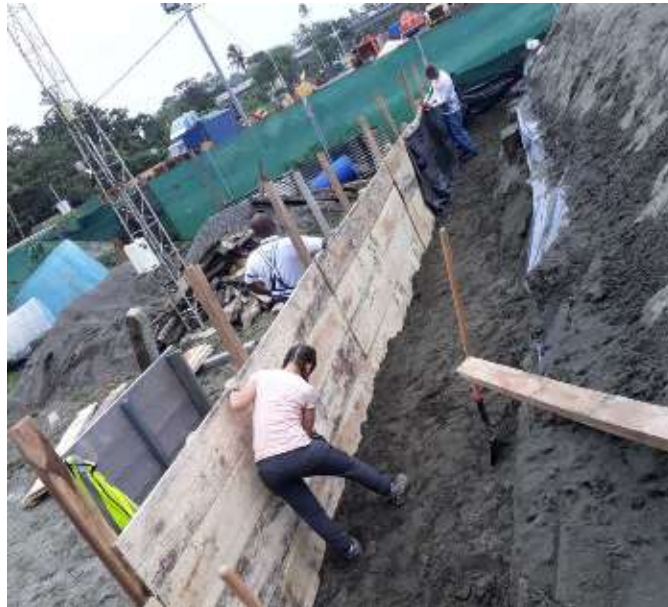
Figura 4. Arena removida de la primera sección de 2m X 17m y colocada en la sección adyacente.
